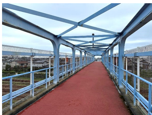
磯道跨線橋(通路部から東側を望む)
