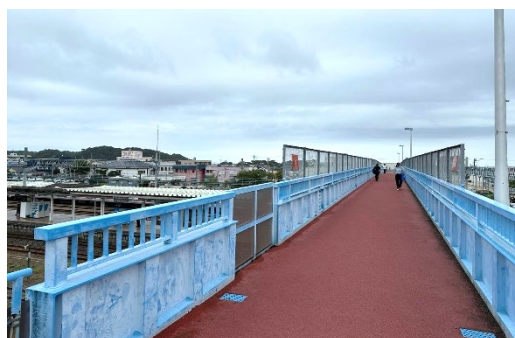
中央跨線橋(通路部から東側を望む)
