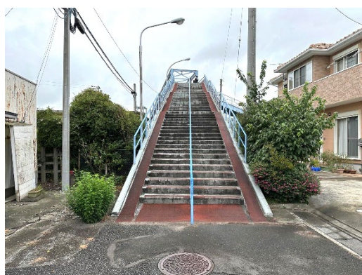
磯道跨線橋(東側上り口)
