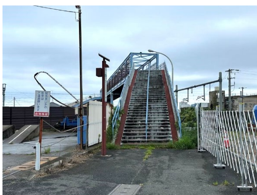
磯道跨線橋(西側上り口)
