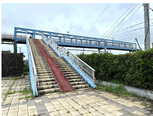
磯道跨線橋(北側上り口)
