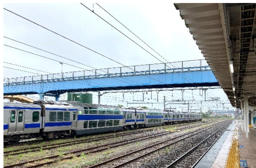
中央跨線橋(駅ホームより望む)
