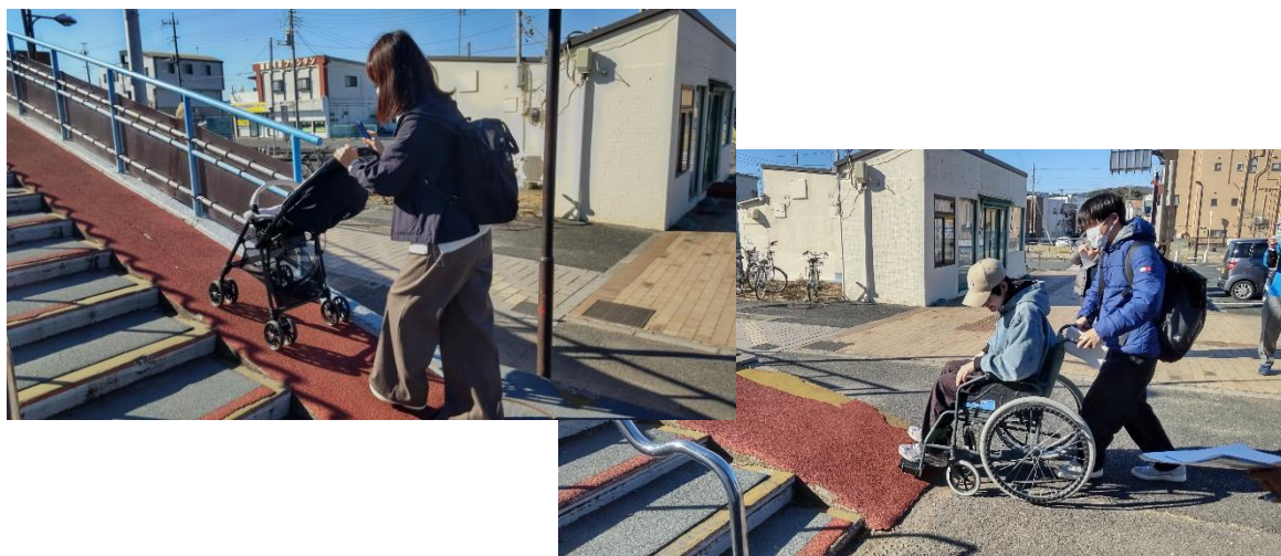
■こ線橋に設置されているスロープ（急傾斜かつ幅が狭く安全な利用が困難）
