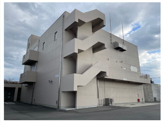
新たに建設された電気棟
