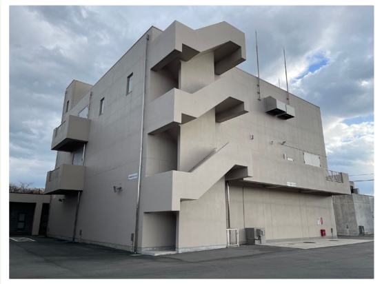
新たに建設された電気棟
