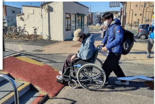
こ線橋に設置されているスロープ（急傾斜かつ幅が狭く安全な利用が困難）
