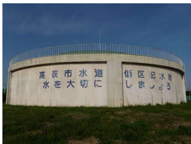
第一浄水場 低区配水池
