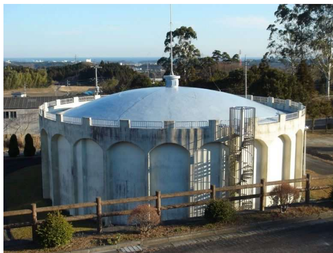
関口浄水場 配水池
