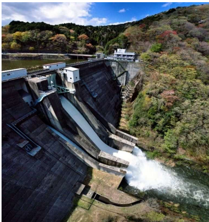
花貫ダム（点検放流）
