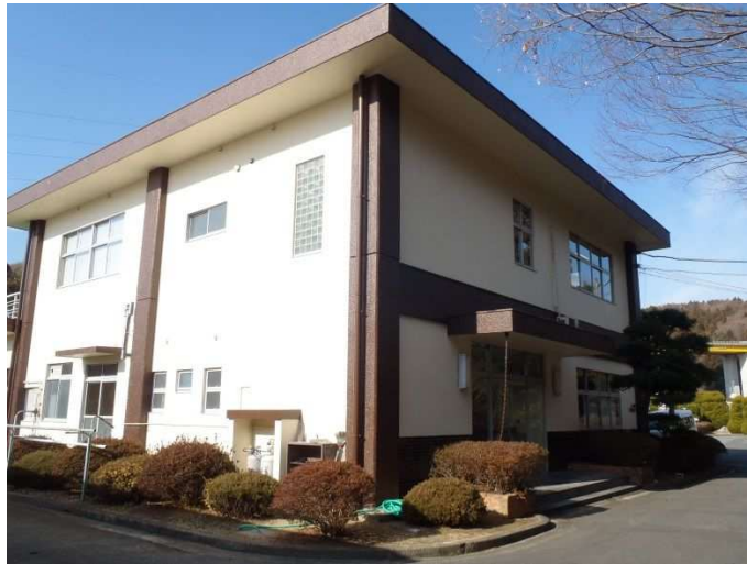
第一浄水場 管理棟
