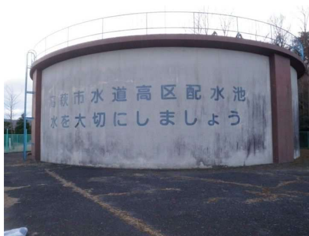
第一浄水場 高区配水池
