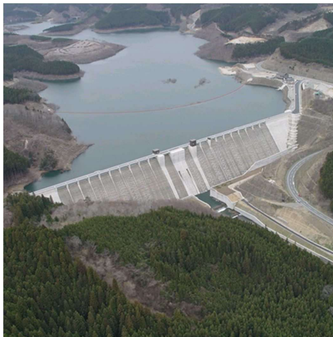
小山ダム（大北川）
