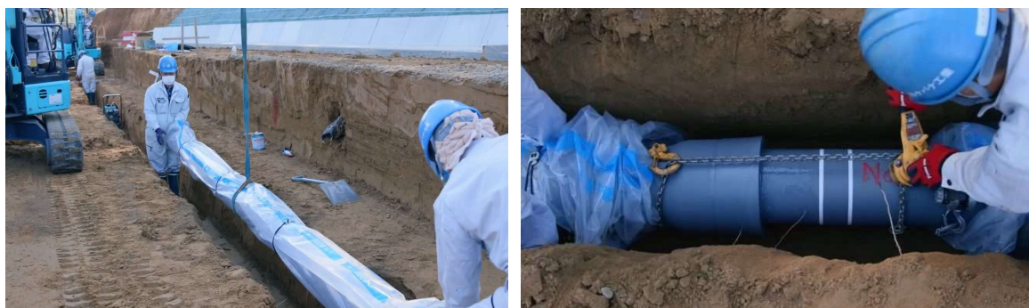
管路の更新作業
