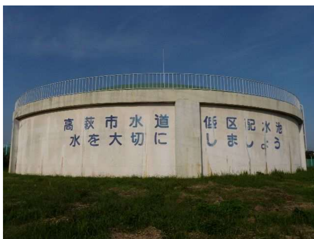
第一浄水場 低区配水池
