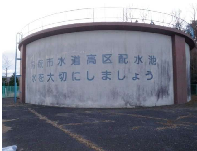
第一浄水場 高区配水池
