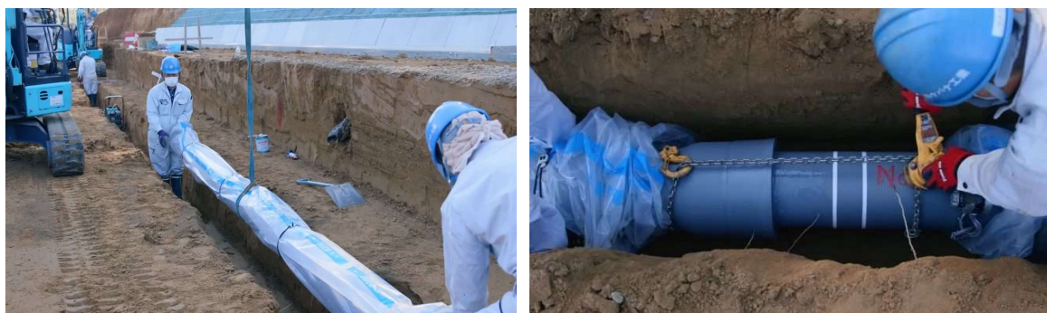
管路の更新作業
