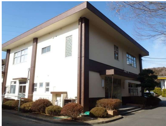
第一浄水場 管理棟
