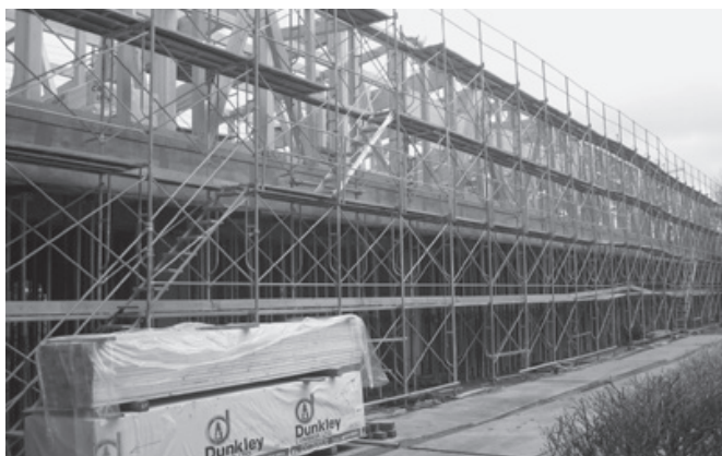
工事中の秋山小学校北側校舎
