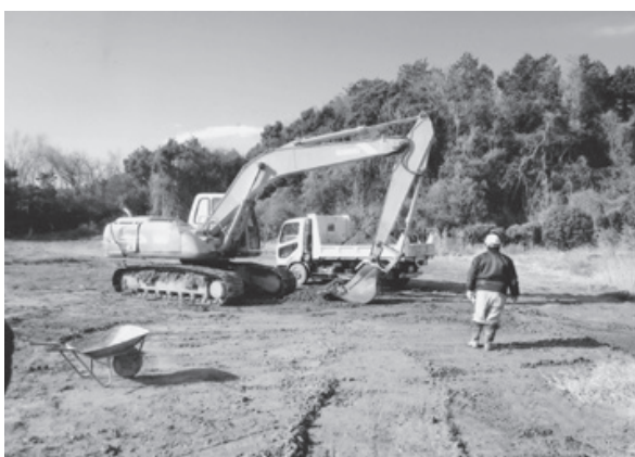
災害廃棄物仮置場整備工事作業中
