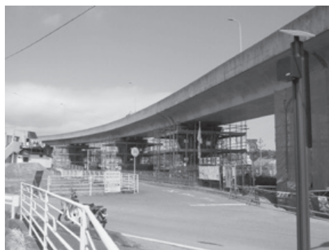
高戸大橋の復旧工事
