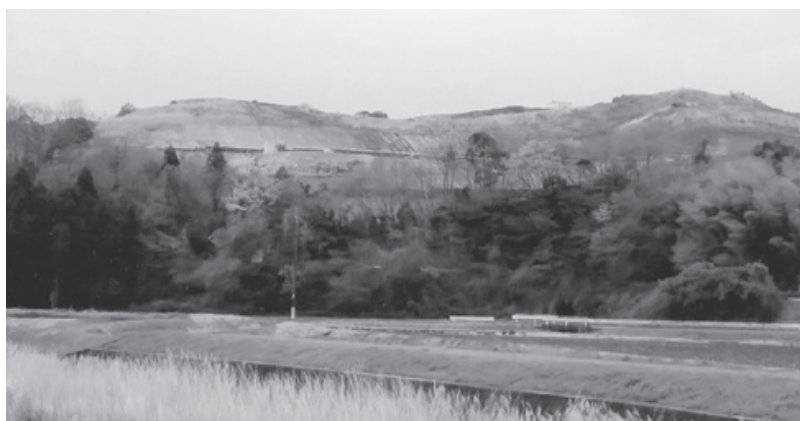
工事中のサンライズカントリークラブ跡地
