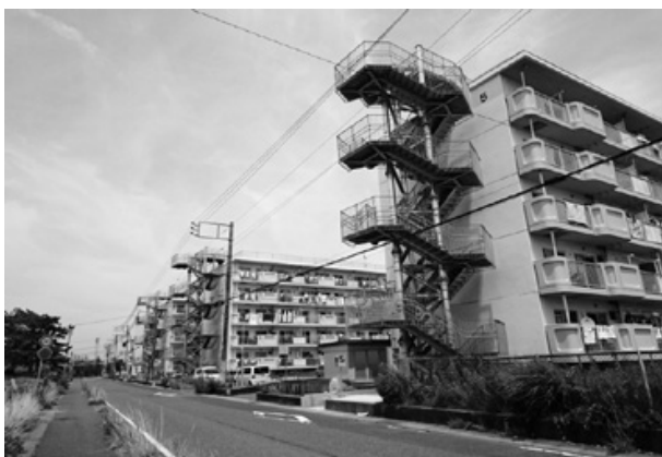
市営高浜住宅津波避難階段
