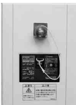
電源遮断装置
