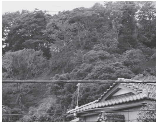
工事予定の崩落箇所(石滝地内)
