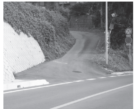
市道1348号線(国道461号から高萩小入口)
