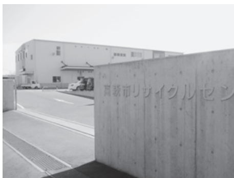
高萩市リサイクルセンター
