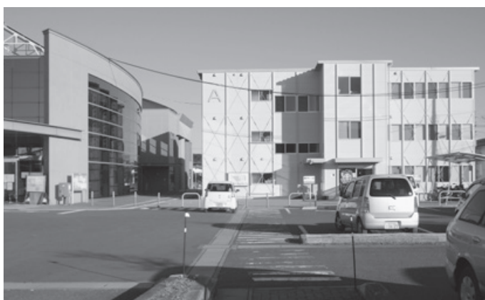
仮設庁舎と総合福祉センター
