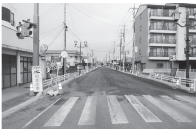
舗装工事中の市道
