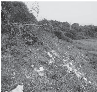
市道法面の不法投棄物
