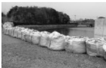
護岸対策が急がれる関根川河口
