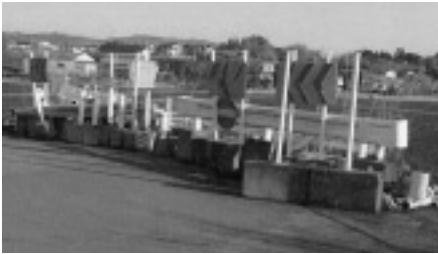
工事が中断している、3・4・1号安良川下手綱線（本町4丁目地内）
