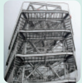
御前崎市の津波避難タワー
