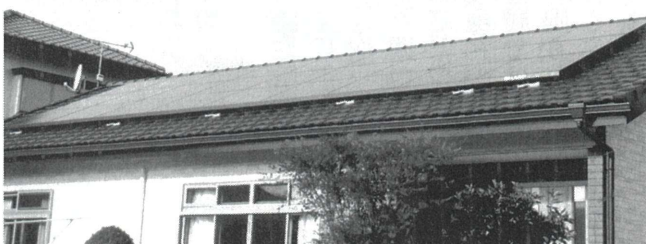
太陽光発電システムが設置された住宅
