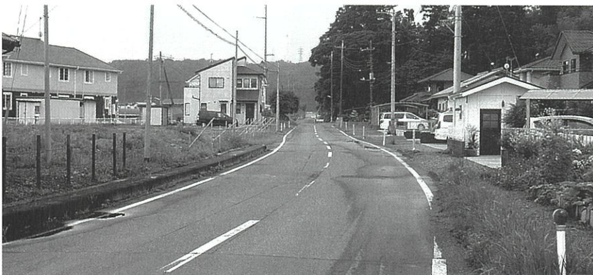
市道205号線（島名小屋下橋付近）
