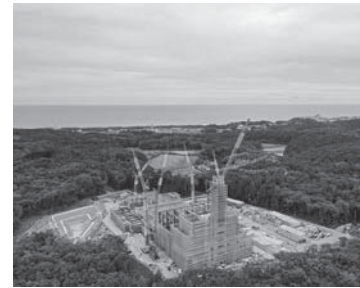
② 建設中のごみ処理施設
