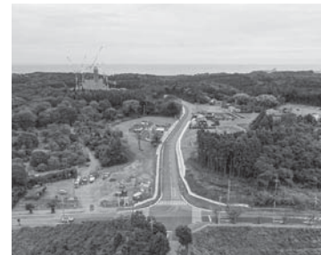
③ 手網工業団地内道路の交差点から東側に約600m幅10mの道路も整備中
