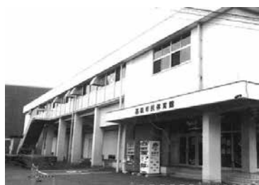
高萩市民体育館 (東側に換気扇移設)
