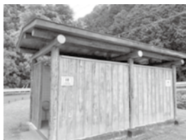
大能駐車場トイレ
